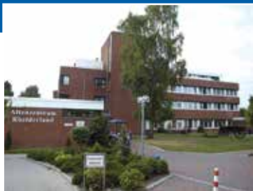
Aussenansicht Altenzentrum „Diakonieverband Rheiderland“
